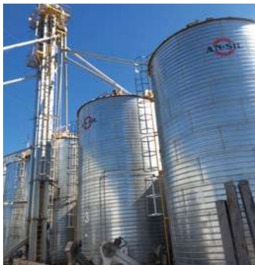
Silo de metal en planta garbancera
